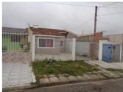
Representação Fachada Descrição Data Foto 05/02/2018
