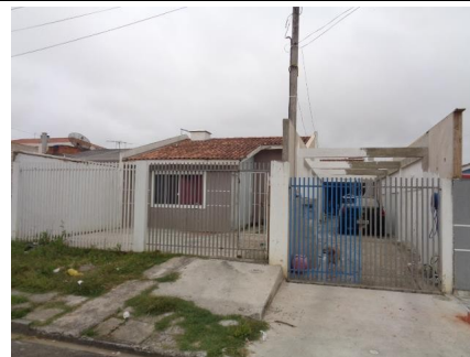
Representação Fachada Descrição Data Foto 05/02/2018
