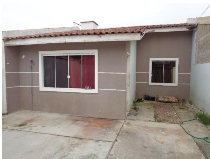
Representação Fachada Descrição Data Foto 05/02/2018
