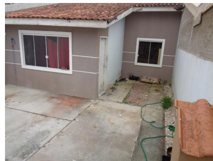
Representação Fachada Descrição Data Foto 05/02/2018
