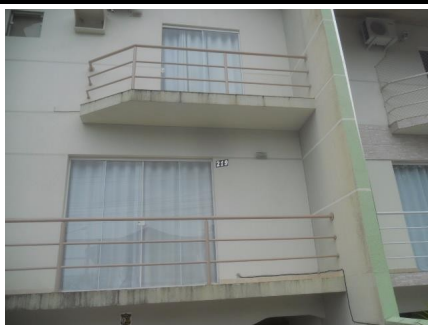
Representação Fachada Descrição Data Foto 23/11/2017
