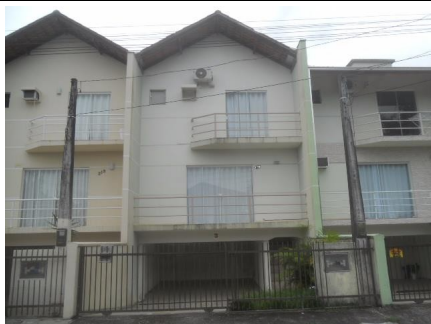
Representação Fachada Descrição Data Foto 23/11/2017
