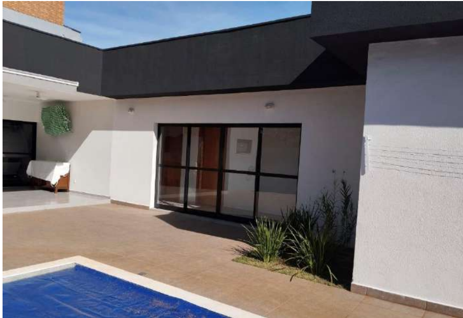
VISTA GERAL DA FACHADA DOS FUNDOS DA EDIFICAÇÃO
