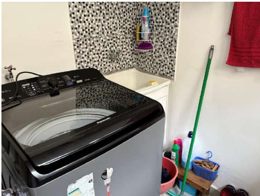
VISTA GERAL DA ÁREA DE SERVIÇO
