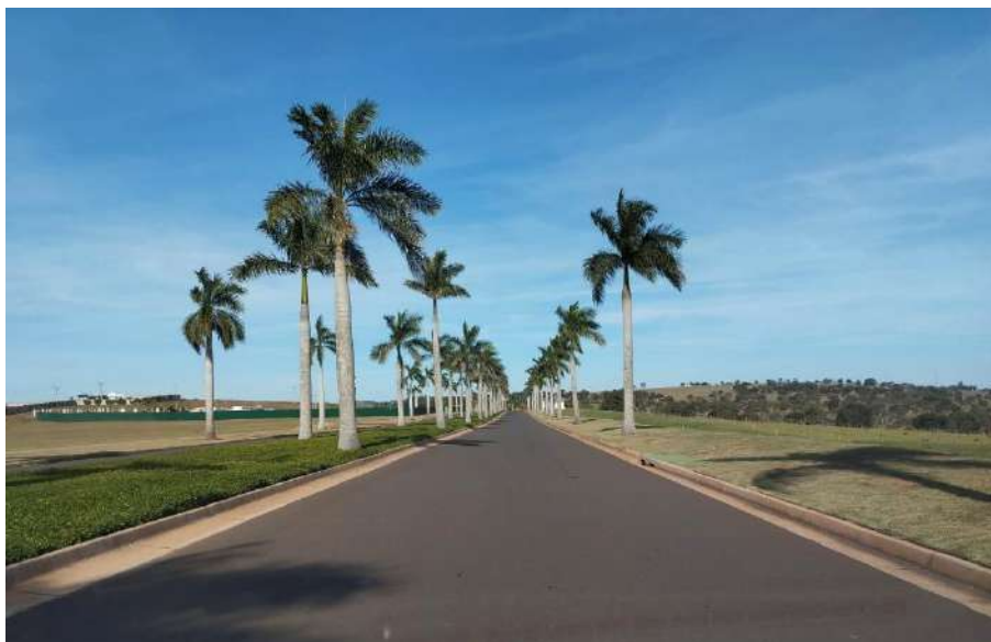
VISTA DA VIA INTERNA DO CONDOMÍNIO
