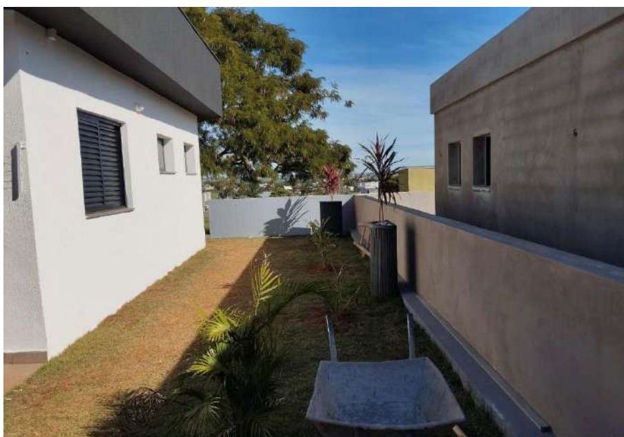
VISTA GERAL DA LATERAL DO IMÓVEL
