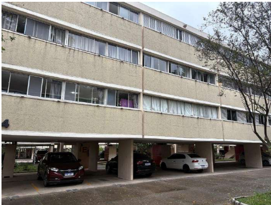
VISTA GERAL DO BLOCO DE APARTAMENTOS Nº 14
