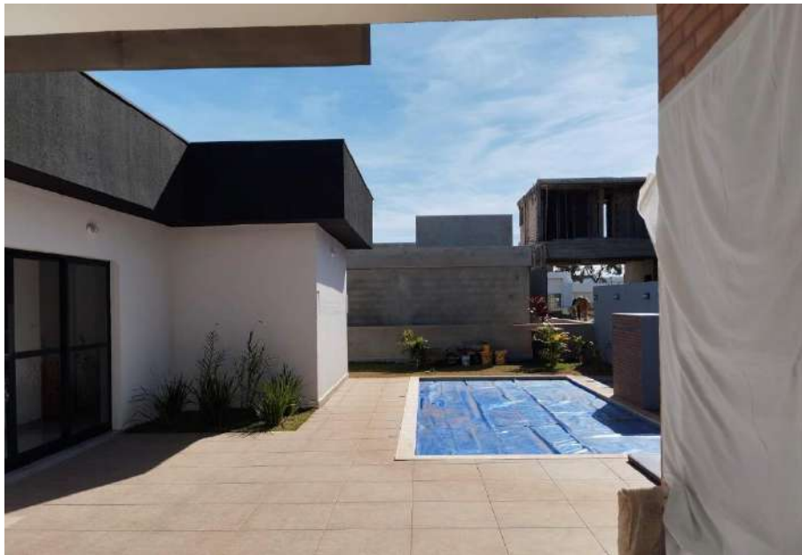
VISTA GERAL DOS FUNDOS DO IMÓVEL
