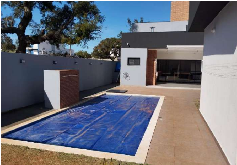
VISTA GERAL DOS FUNDOS DO IMÓVEL
