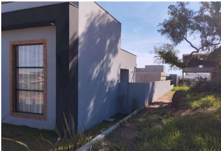
VISTA GERAL DA LATERAL DO IMÓVEL
