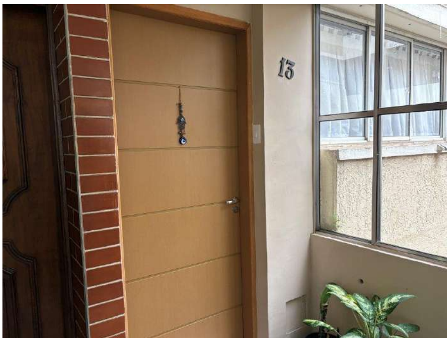
VISTA GERAL DA PORTA DE ACESSO DO APARTAMENTO AVALIANDO
