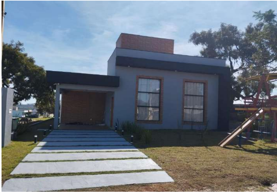
VISTA GERAL DO IMÓVEL
