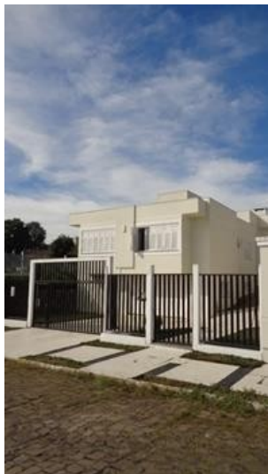
Representação Fachada Descrição Data Foto
