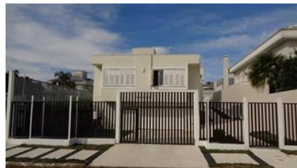
Representação Fachada Descrição Data Foto
