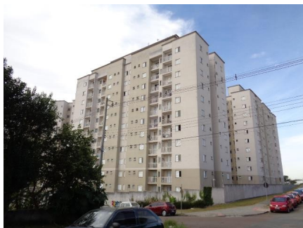
Representação Fachada Descrição Data Foto 16/05/2018
