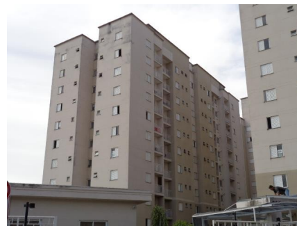
Representação Fachada Descrição Data Foto 16/05/2018
