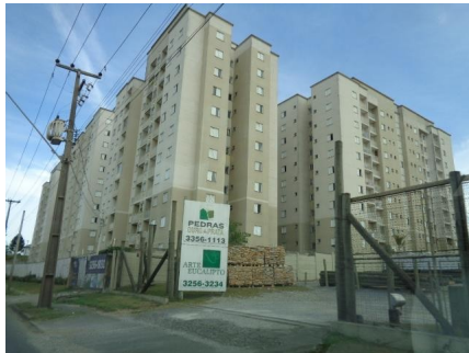
Representação Fachada Descrição Data Foto 16/05/2018
