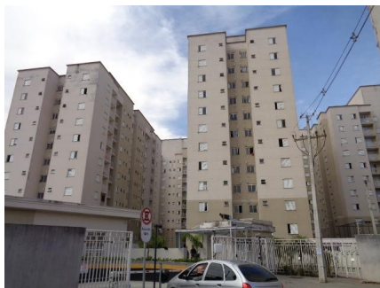
Representação Fachada Descrição Data Foto 16/05/2018
