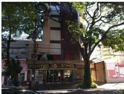
Representação Fachada Descrição Data Foto 01/05/2018
