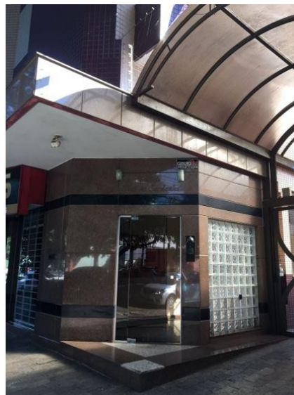
Representação Fachada Descrição Data Foto 01/05/2018
