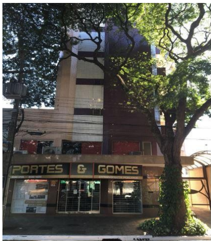
Representação Fachada Descrição Data Foto 01/05/2018
