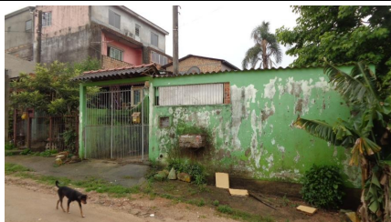
Representação Fachada Descrição Data Foto
