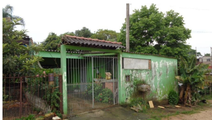
Representação Fachada Descrição Data Foto
