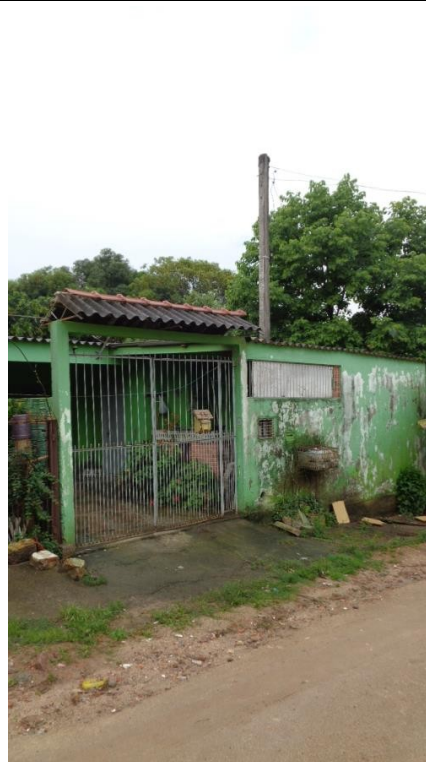
Representação Fachada Descrição Data Foto
