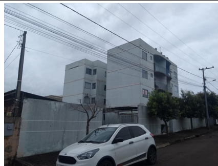
Representação Fachada Descrição Data Foto 24/09/2018
