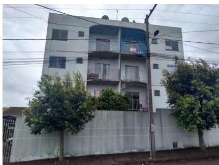
Representação Fachada Descrição Data Foto 24/09/2018
