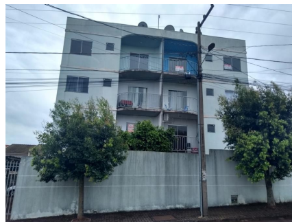
Representação Fachada Descrição Data Foto 24/09/2018
