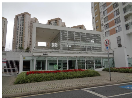
Representação Fachada Descrição Data Foto 14/02/2018
