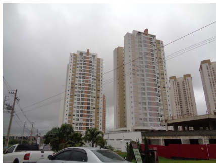
Representação Fachada Descrição Data Foto 14/02/2018
