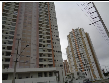
Representação Fachada Descrição Data Foto 14/02/2018
