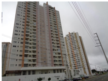
Representação Fachada Descrição Data Foto 14/02/2018
