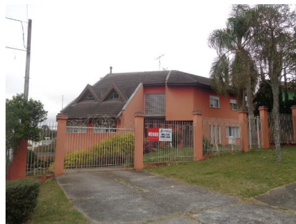
Representação Fachada Descrição Data Foto 24/07/2018
