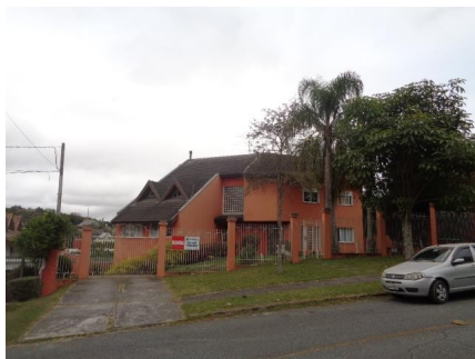
Representação Fachada Descrição Data Foto 24/07/2018
