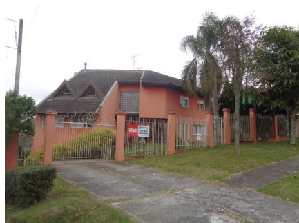
Representação Fachada Descrição Data Foto 24/07/2018
